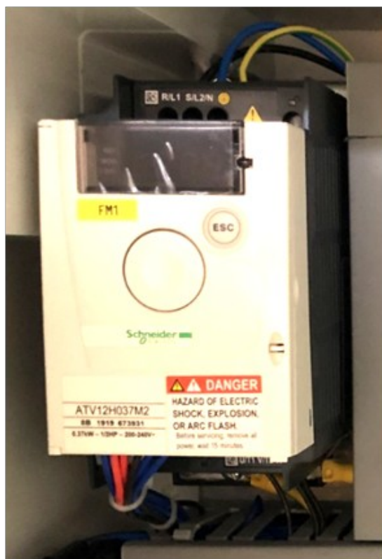
Obr. 25 - Frekvenční měnič
